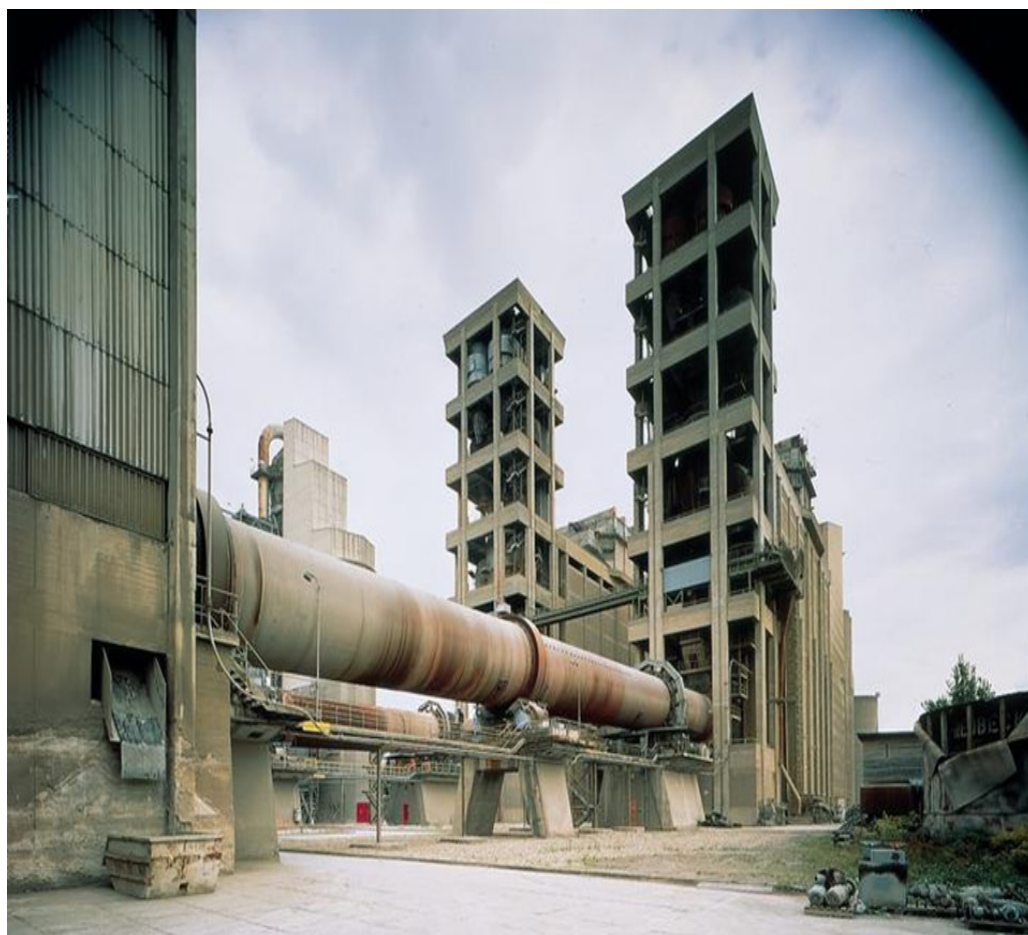
Figura 1: Forno de cimento
